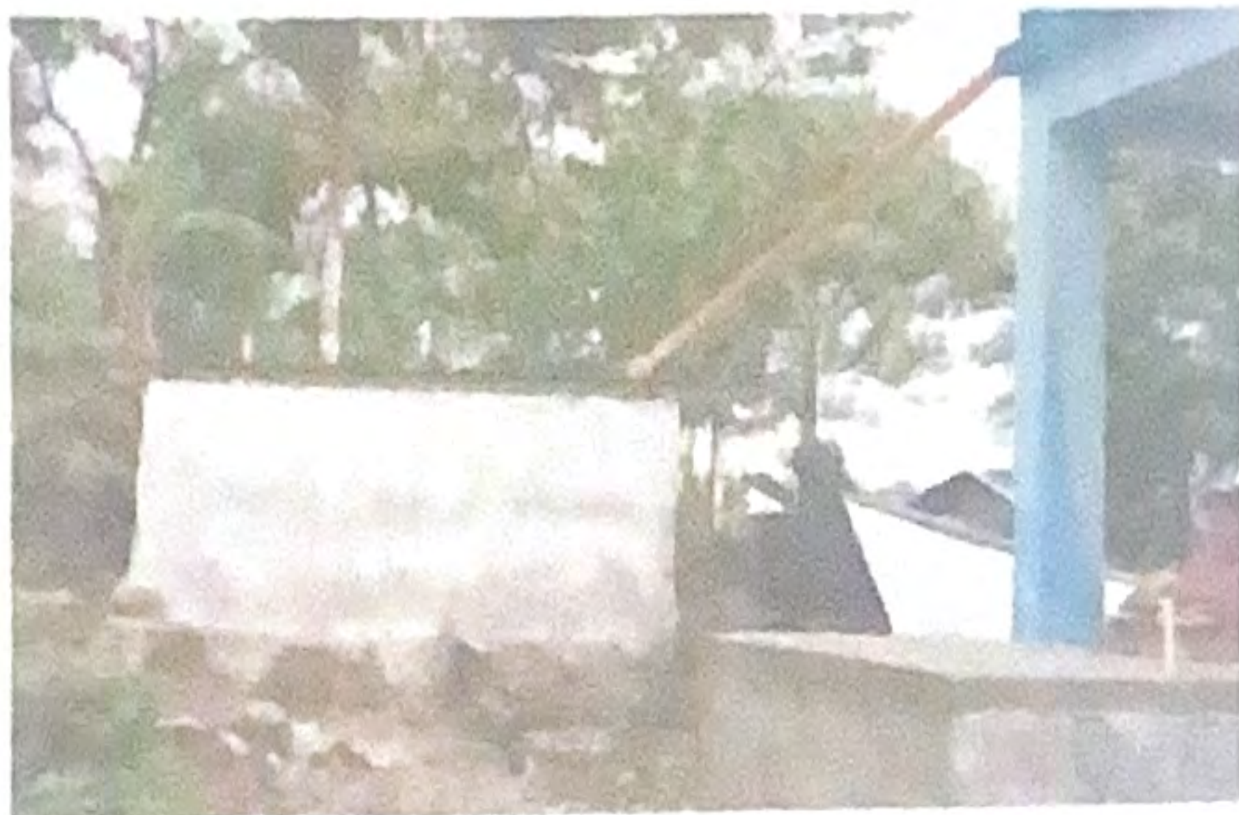
Reparación y mantenimiento de cisternas, depósitos de agua
